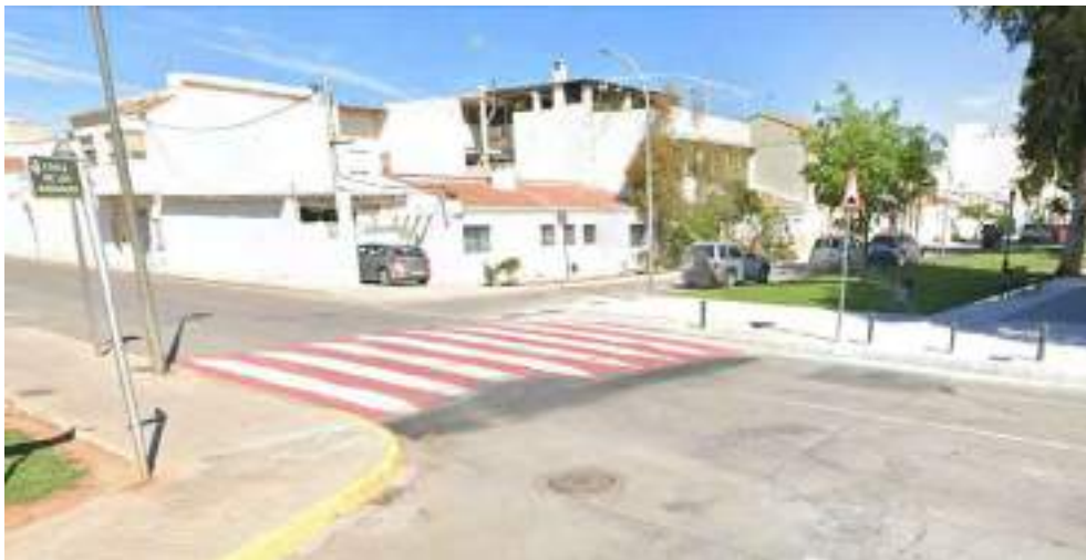
Ilustración 54. Combinación de lomo y paso peatonal entre Calle de los Naranjos y Calle Ángel Custodio
