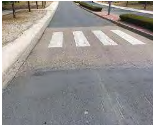
Ilustración 51. Demarcaciones alertadoras fresada. Fuente: Asfalvías, 2023
