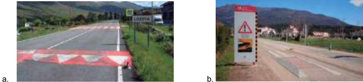
Ilustración 41. a. Combinación de lomo y paso peatonal sobre lomo en el primer tramo de una travesía. b. Almohada en el acceso a una travesía. Fuente: DGT, 2019
