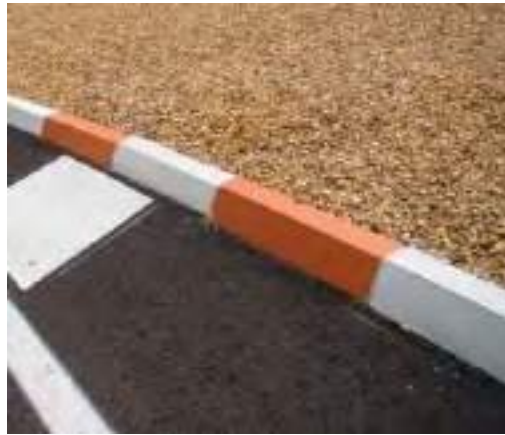
Ilustración 55. Ejemplo de bordillo pintado con franjas de color blanco y rojo. Fuente: marcas viales, S.A., s.f.
